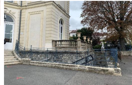
Création d'un accès PMR et entretien des gardes corps
